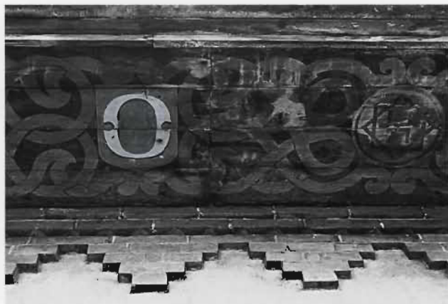
Etat de conservation d'une partie du berceau en bois en 1984-1985 environ et frise décorative en briques couronnant l'élévation. On aperçoit encore à ce moment, ici et là, les traces du décor peint d'origine sur les rangées supérieures des briques (badigeon à la chaux de couleur brique et joints à la chaux).
