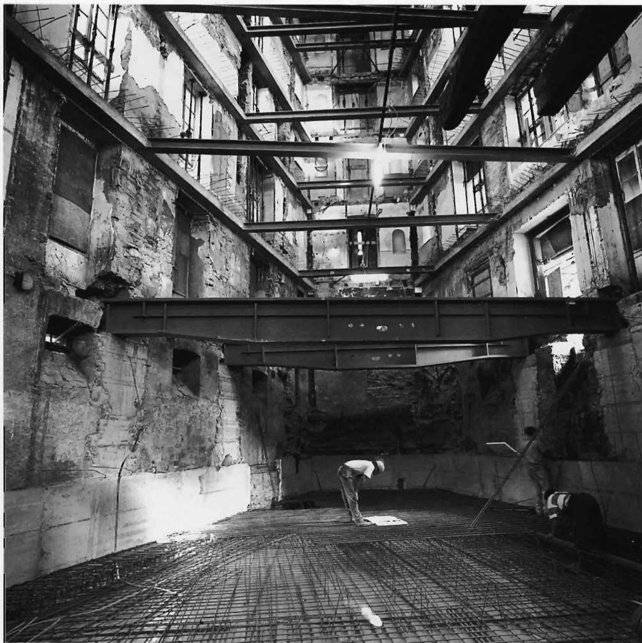
Chantier en cours. Mise en place des nouvelles structures porteuses intérieures.
